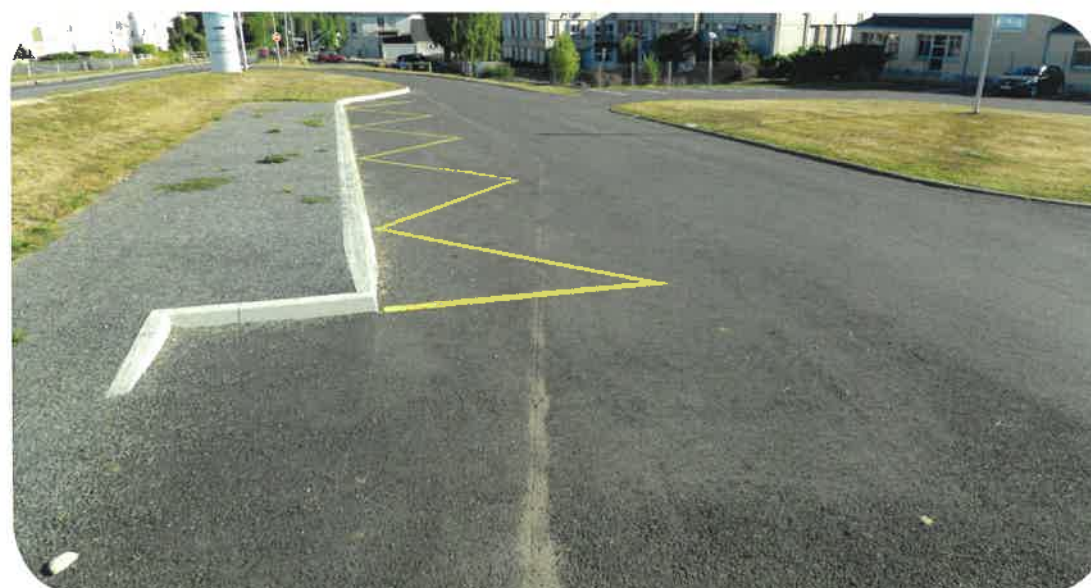
Quai de bus près de la piscine de Château-Renard
