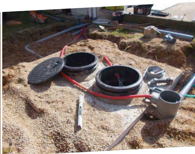
Contrôle de conception et contrôle des travaux pour une réhabilitation d'un dispositif d'assainissement non collectif
